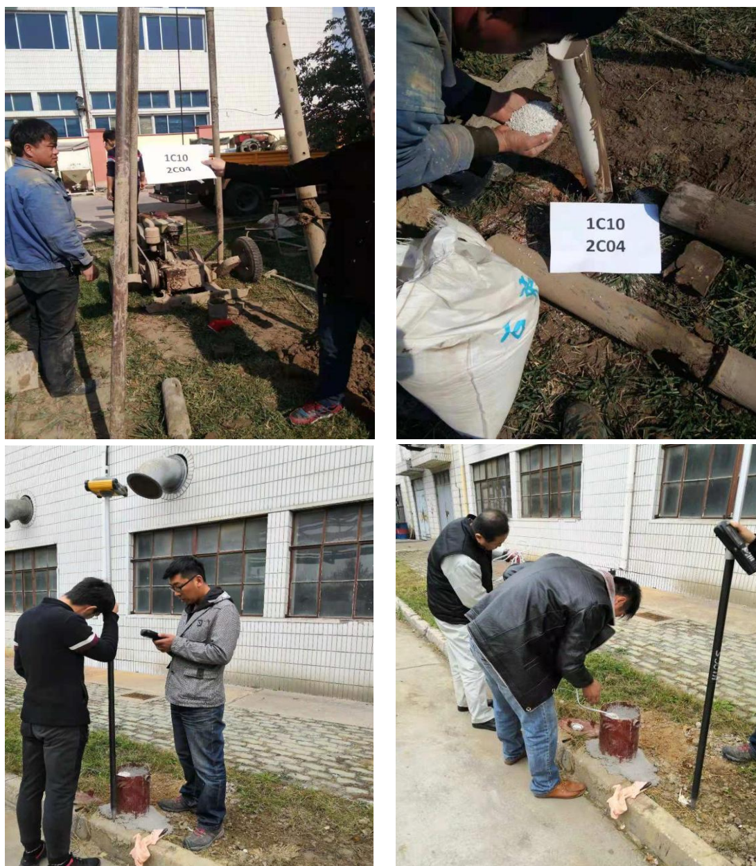
图 2.3-1 现场施工照片
